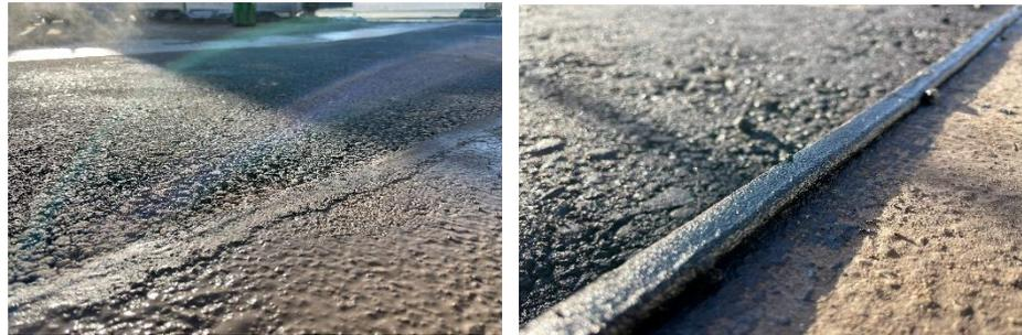
Das **Corabit KK Winkelband** ist ein für den Straßenbau entwickeltes kaltklebendes Fugenband auf Bitumenbasis mit einer synthetischen Klebeschicht und einem überstehenden Profil.
